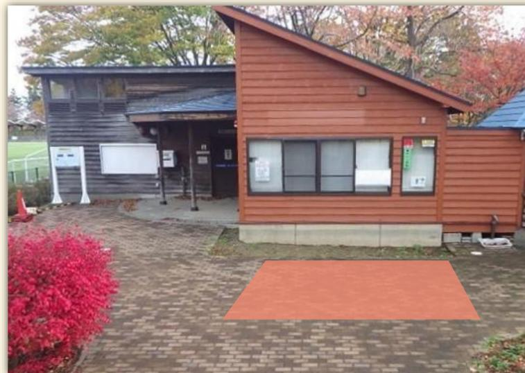
雨庭の地表面には0.25mの植栽基盤を施した。地表部にある程度雨水を滞留させる目的から窪地を形成し、平時は修景地（花壇）として、降雨時は雨水滞水地としての機能を果たせるような形状とした。
